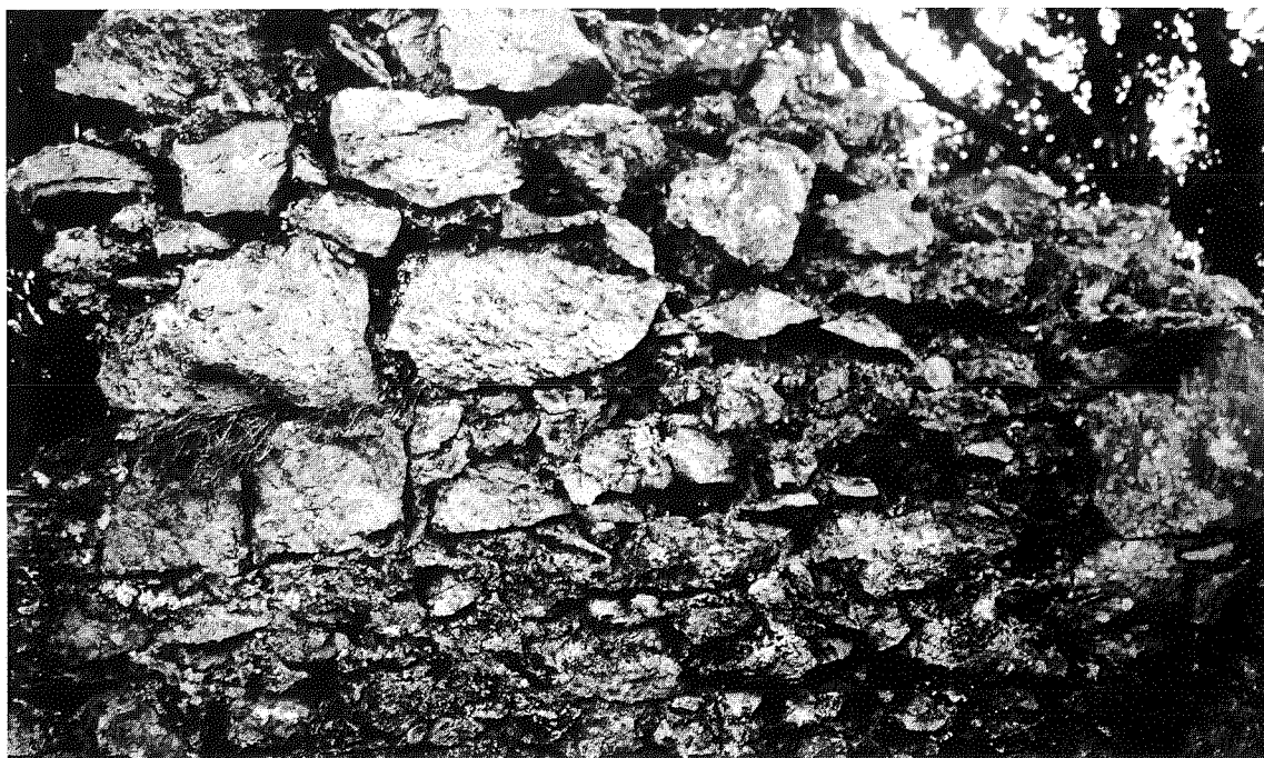
3. Casilini di S. Sosti, chiesa: interno muro meridionale presso l'angolo S.O. (part. della struttura muraria).
