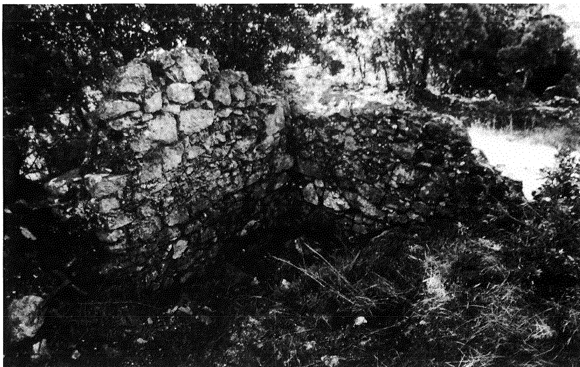
2. Casilini di S. Sosti, chiesa: interno, angolo S.O.
